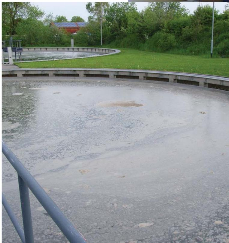
Das Nachklärbecken in Buchloe vor Versuchsbeginn; Schlieren und Schwimmstoffe auf der Nachklärung verschlechtern die Ablaufwerte.
