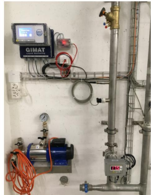
Messanordnung: Wärmeträger Fernüberwachung
