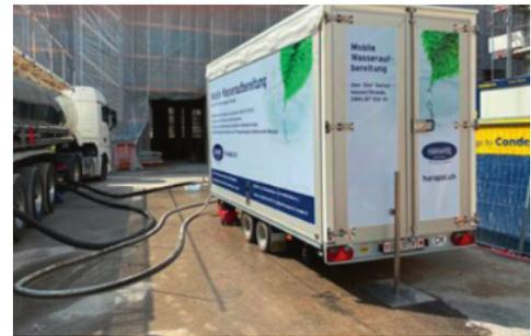
VE-Wasseranlage und Tankzug mit dem Wärmeträgerkonzentrat
